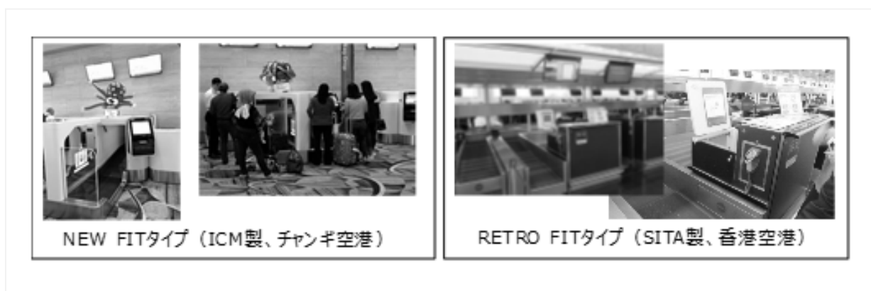
図-2 SBD 機器 NEW FIT と RETRO FIT 事例
