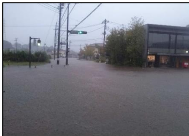
浸水状況(平成26年10月)
