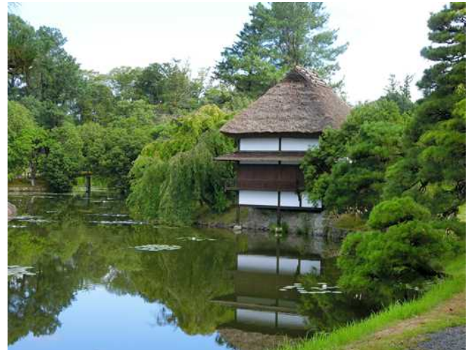
風月軒：池にせり出して建てられた8畳の離れ座敷
