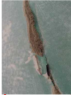
損傷（クラック）発生の状況
