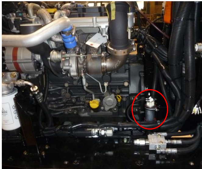
機関室内部写真
