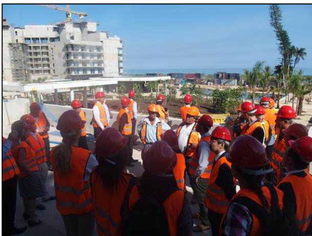
<バラデロのホテル建設現場視察>
