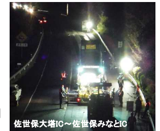
写真4 夜間工事の状況
