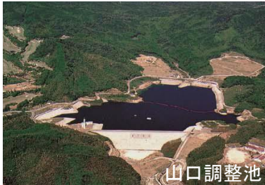
筑後川下流土地改良事業造成施設 (H23)
