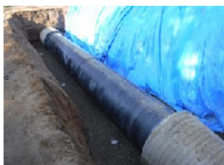
鋼管敷設状況
