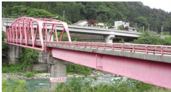
<音沢橋の状況>
