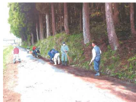
落葉清掃状況(側溝閉塞の抑制)
