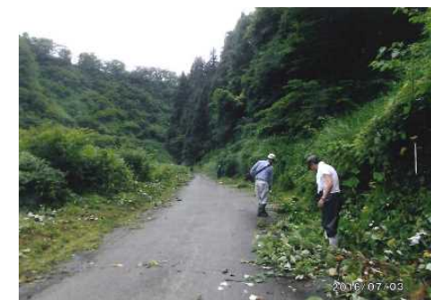
道路法面の草刈り状況
