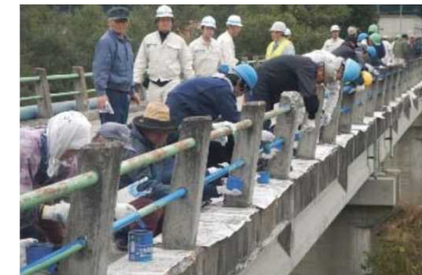
産学官民協働による橋守(欄干塗装)
