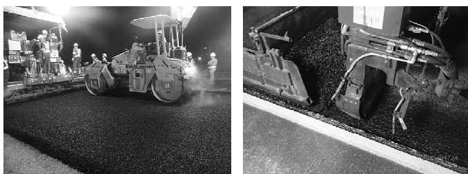
写真-2 POSMACによる舗設状況
