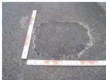
緊急補修 完了時
