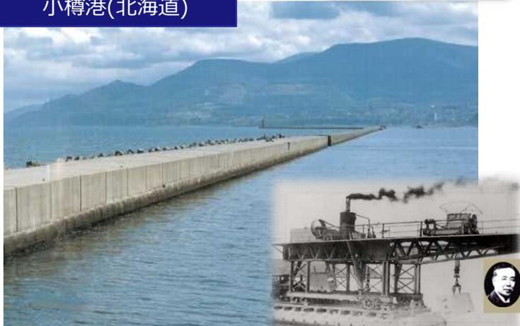
防波堤上に軌道で移動し斜地ブロックを設置する英国製積岸機
