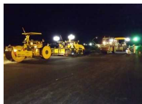
(老朽化した滑走路舗装の改良)
