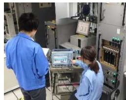
(航空保安施設点検実施状況)
