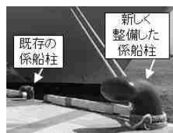
係船柱の整備事例
