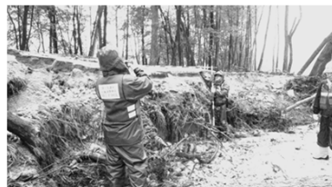
被災状況調査 （清水町）
