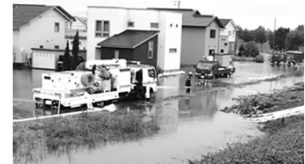
排水ポンプ車 緊急排水作業（音更町）
