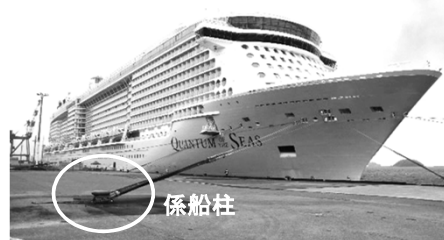
大型クルーズ船に対応した係船柱*1・防舷材*2の設置
