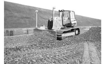
ICT建設機械による施工
