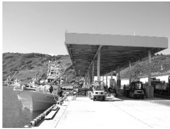
【高度衛生管理対策：屋根付き岸壁、清浄海水導入施設】
