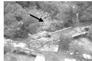
流木被害の状況（伊達市紋別川）
