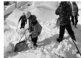
改良した命綱を着用した屋根雪下ろし演習
