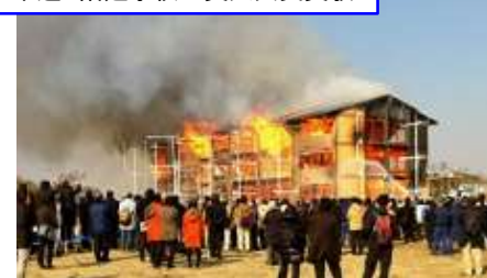
木造3階建て学校の実大火災実験
