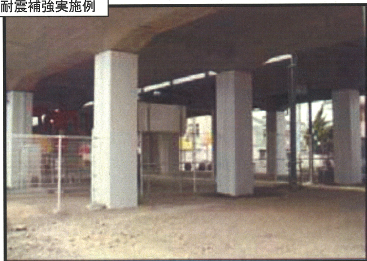
耐震補強実施例
