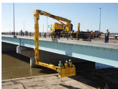
橋梁点検車による点検
