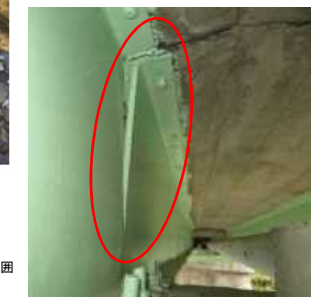
主桁の変形
