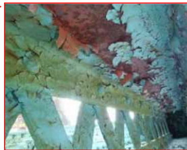
鋼材の腐食
