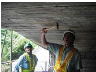
目視及びハンマーによる打音検査
