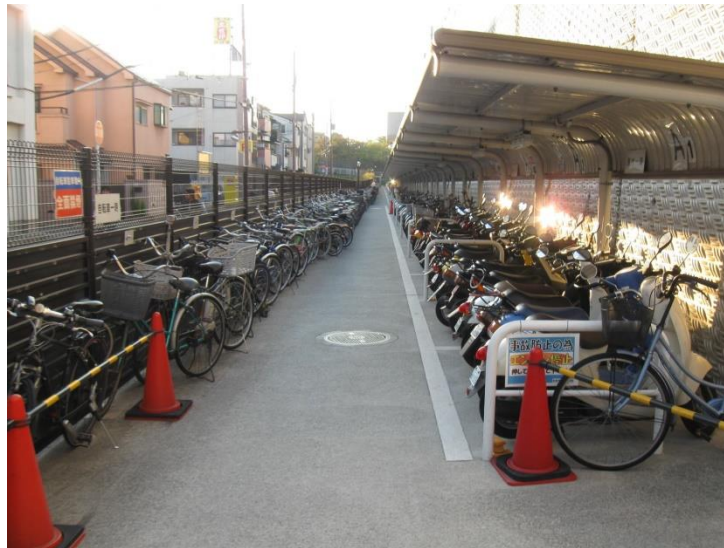
図Ⅲ-2-7 自転車駐車場の設置状況
