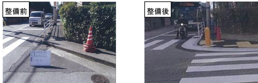
図Ⅲ-2-10 歩道の段差解消例
