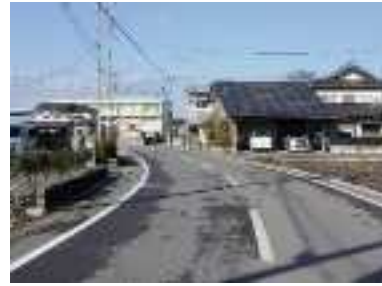
町道 2023 号祖母井本線
