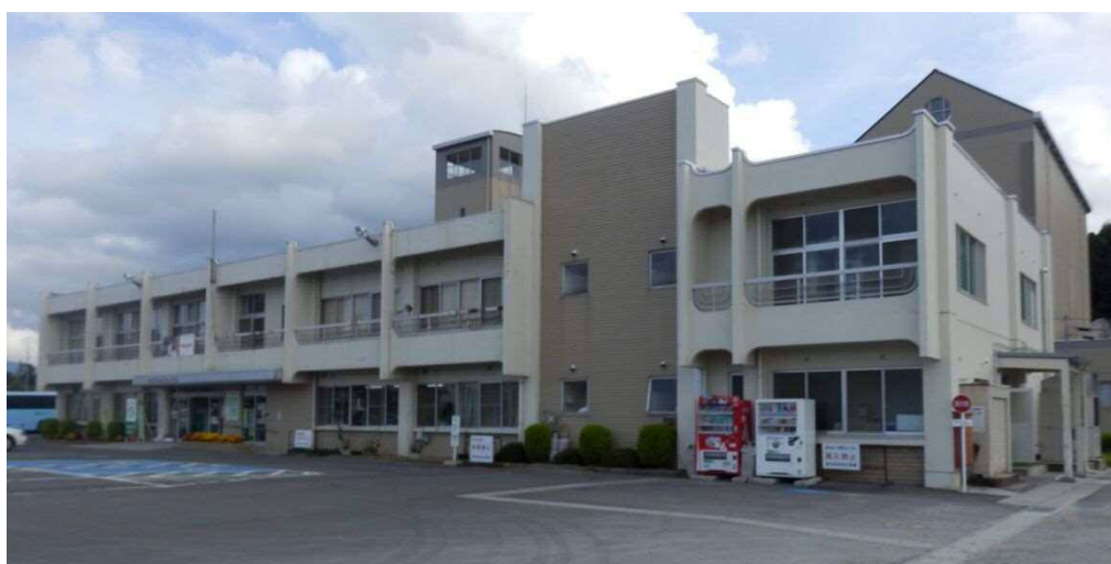
図 39 船引公民館建物外観
