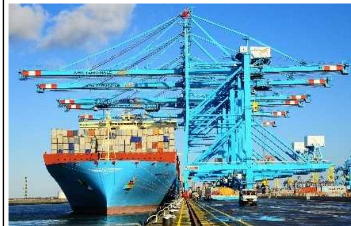
④本船荷役(ガントリークレーン)の遠隔操作化・自動化
