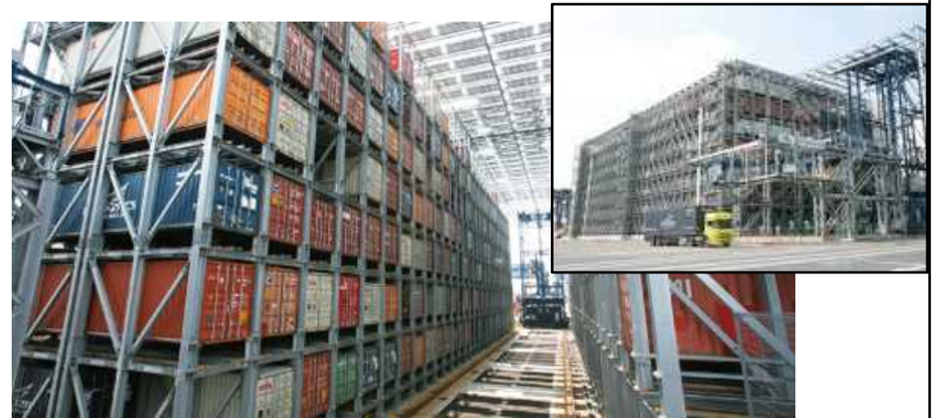
③コンテナ立体格納庫
