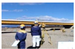
【測量】レーザースキャナーによる3次元測量
