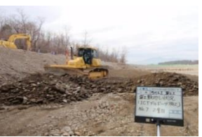
【施工】ICT建機による施工
