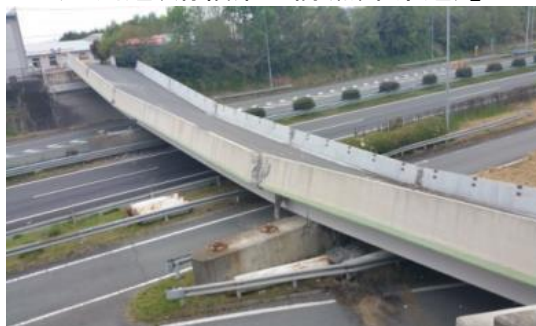
【跨道橋の落橋 (九州道、府領第一橋(熊本県道))】
