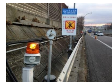
赤外線カメラ(左写真)で検知すると警告灯(右写真)で警告
