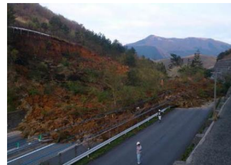
【切土法面の崩壊 (大分道 由布岳PA付近)】
