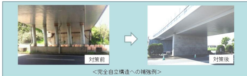
<完全自立構造への補強例>
