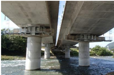
<対策例1: 橋脚全体の補強>
