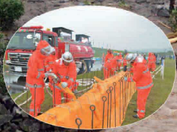
砂袋の設置作業
