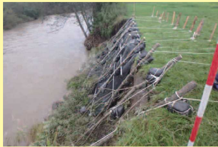
釧路川左岸:木流し工により川表堤腹崩壊拡大防止。
