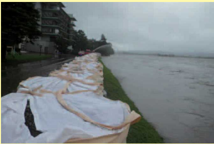
十勝川左岸:大型土のう設置により越水を防止。
