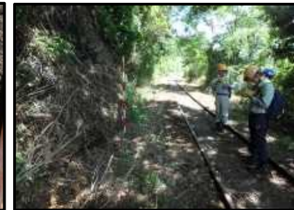
6k320m 落石(岩斜面崩落)
