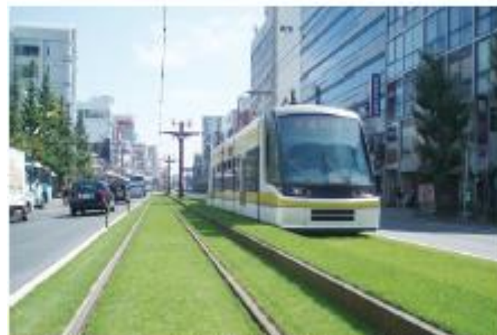
既設の路面電車の軌道敷を芝生化した鹿児島市市電
