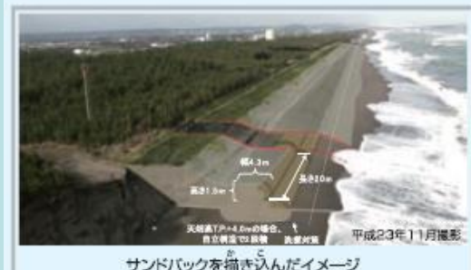
自然の堤防である背後砂丘を保全するため、養浜砂に埋まる「埋設護岸」を整備(宮崎海岸)
