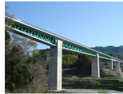
複合トラス橋
