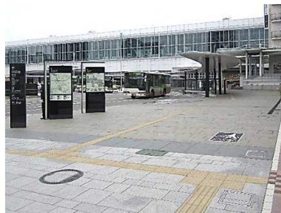
駅前広場における視覚障害者誘導用ブロック及び上屋の連続的な整備
