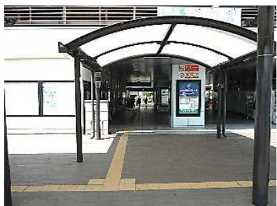
駅等における上屋、視覚障害者誘導用ブロックの連続的な整備
