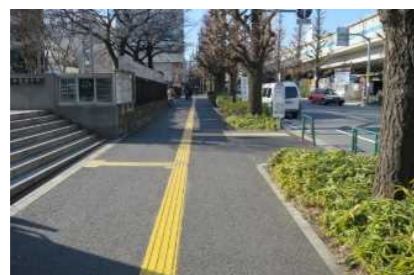
視覚障害者誘導用ブロック
