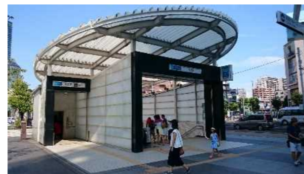
<駅等における視覚障害者誘導用ブロックの連続的な整備(豊洲駅前)>
