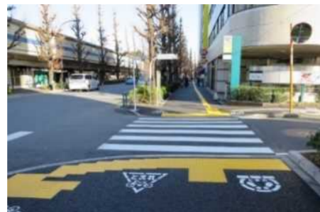
視覚障害者誘導用ブロックの設置、歩車道の段差解消
