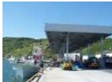
屋根付き岸壁の整備
