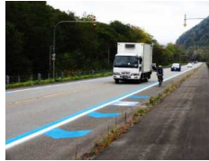
車道への通行位置明示
