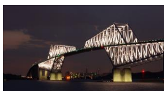
2,800のデータ計測によるモニタリングシステムによる長寿命化（東京ゲートブリッジ）
