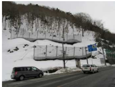
雪崩防止柵の整備 ⇒ハード対策による雪害対策
