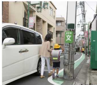
＜歩行の支障となる電柱＞
