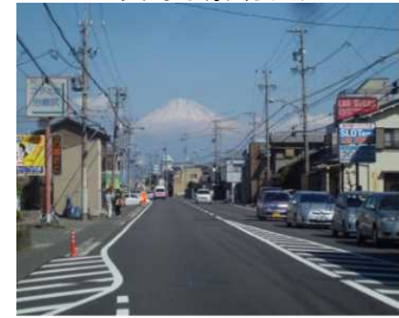
＜美観を損ねる電柱・電線＞
