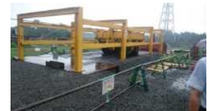
▲輪荷重試験器による耐久性能試験の状況
