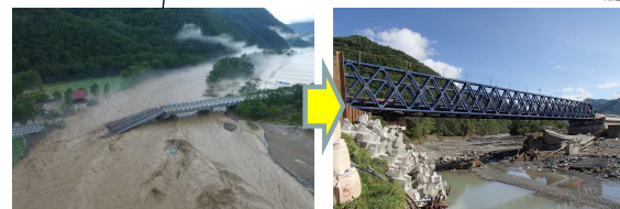
国道274号 千呂露橋・落橋仮橋にて復旧(9/13)
