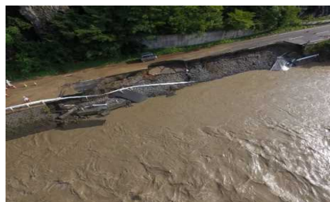
河川氾濫による冠水、 道路崩壊(岩手県: 小本川)
