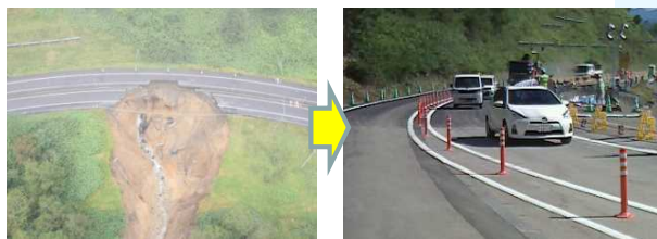
国道38号 狩勝峠 法面崩壊(9/11に一般車両通行可)
