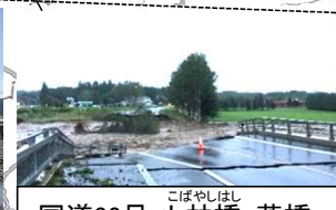
国道38号 小林橋・落橋仮橋にて復旧中
