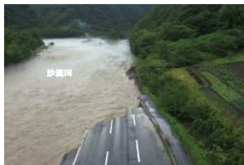
河川氾濫による 国道274号の崩壊(北海道: 沙流川)
