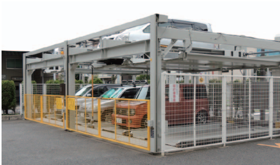
前面ゲートと柵を設けた機械式駐車装置の例
