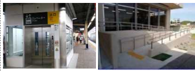
エレベーター スロープ
