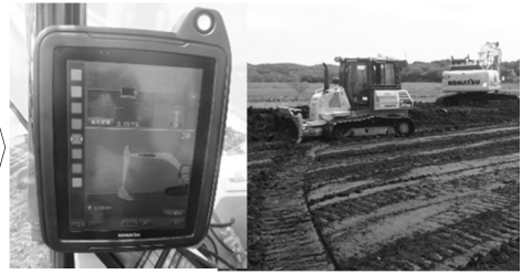
ICT建機による施工
