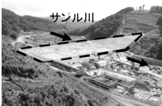
工事中のサドルダム
