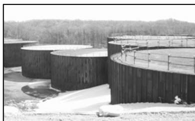
樽前山における砂防堰堤の整備
