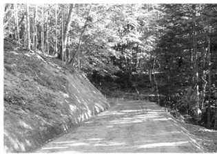
路網（森林作業道）の整備
