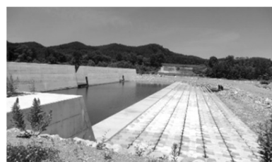
戸蔭別川第2号砂防堰堤 (帯広市)
