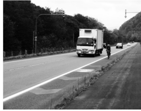
車道への通行位置明示
