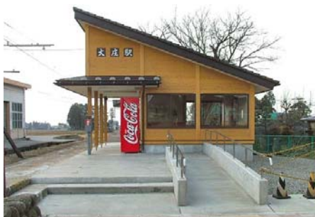
図 1-2-5 改修された大庄駅
