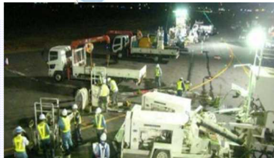
限られた時間での夜間作業
