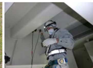
↑超音波探傷違法による鋼橋の亀裂を半自動で効率的に検出する非破壊検査技術
