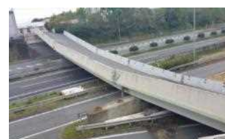
写真-8 ロッキング橋脚を有する 橋梁の落橋 (府領第一橋)
