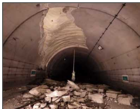
写真-16 俵山トンネル(県道) たわらやま
