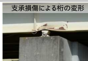
写真-5 九州自動車道 (木山川橋)
