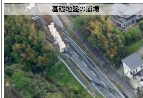
写真-9 国道443号 (益城町)
