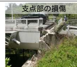
写真-6 熊本高森線 (桑鶴大橋)
