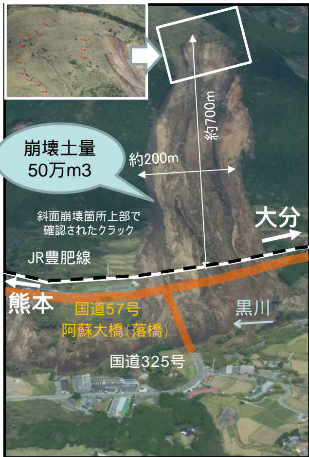
写真-5 斜面崩落と阿蘇大橋の落橋 (国道57号・国道325号)
