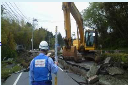
重機による盛土復旧作業を実施
