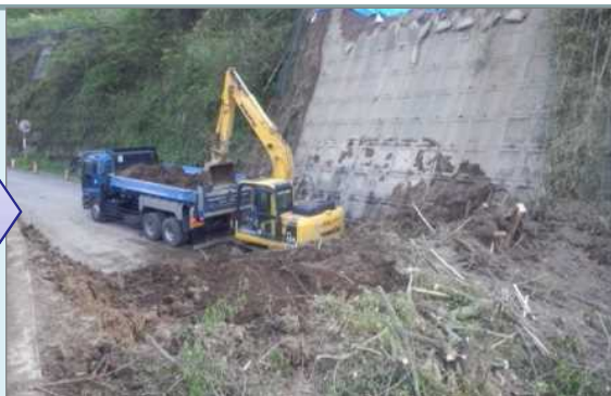
重機による道路啓開作業を実施
