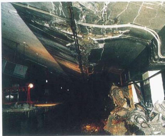
プラットフォーム階の状況
