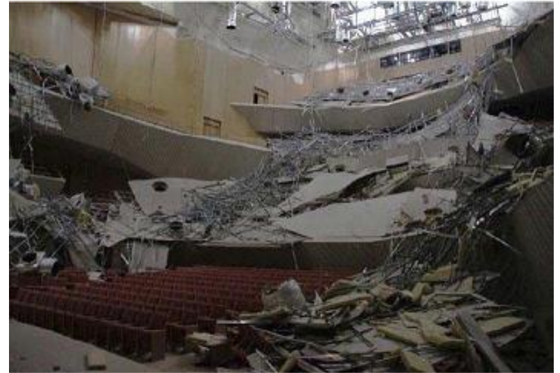
東京九段会館天井落下事故の状況 出典：H24 吊り天井構造の耐震性能評価に関する研究（近畿大学工学部）より
