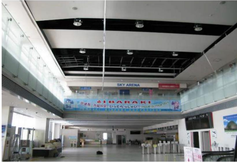
茨城空港ターミナルビルの天井被害の状況 出典：2011年東北地方太平洋沖地震被害調査報告より
