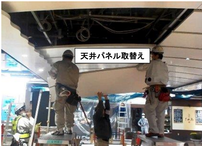
天井パネル取替え作業
