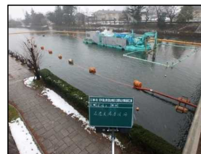
【汚泥浚渫の状況】
