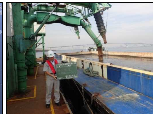
【新海面処分場での土砂投入】
