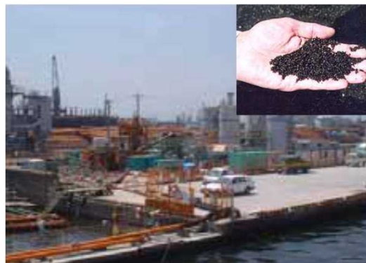
陸上において汚泥を固化処理
