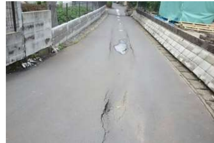
下水管上部の道路陥没状況
