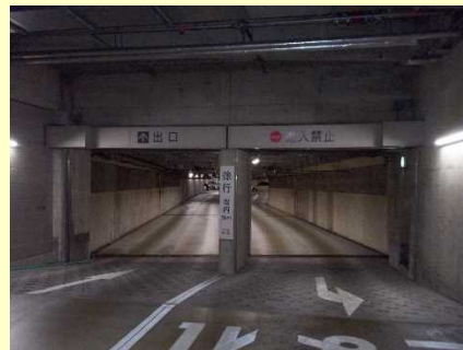
駐車場を繋ぐ地下通路
