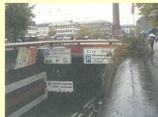
広場の手前で地下へ潜る幹線道路
