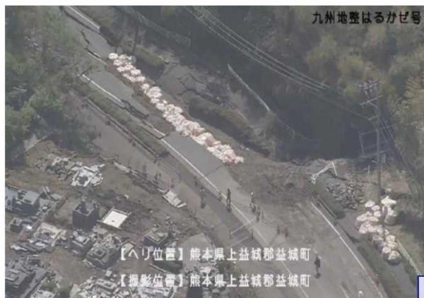
■国道443号(益城町)
