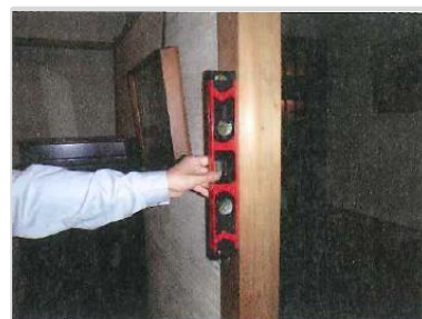
水平器による柱の傾きの計測
