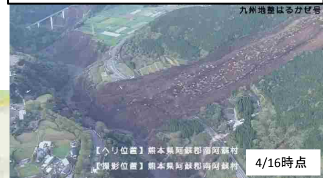
阿蘇大橋地区斜面崩壊(国道57号・325号)
