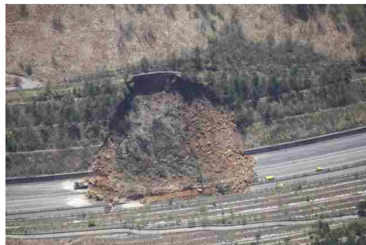
ゆふだけ ① 由布岳PA付近 土砂崩落
